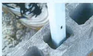
支柱を立てます。
